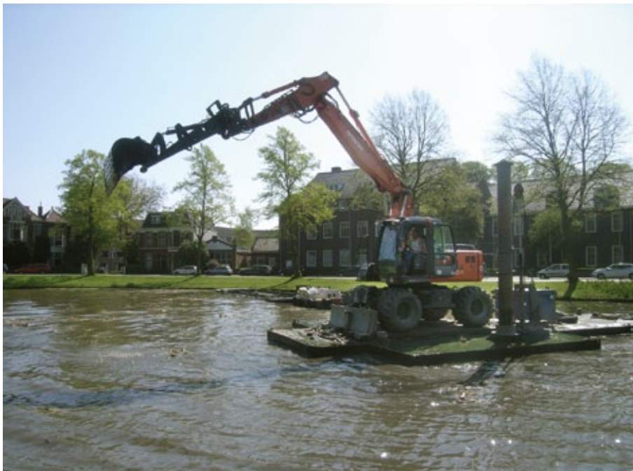
Afb. 3.1 De watergangen werden machinaal uitgebaggerd met een graafmachine die op een kraanponton stond. Het opgebaggerde slib werd in beunbakken naar de Tweede Maasvlakte afgevoerd en daar gezeefd.
