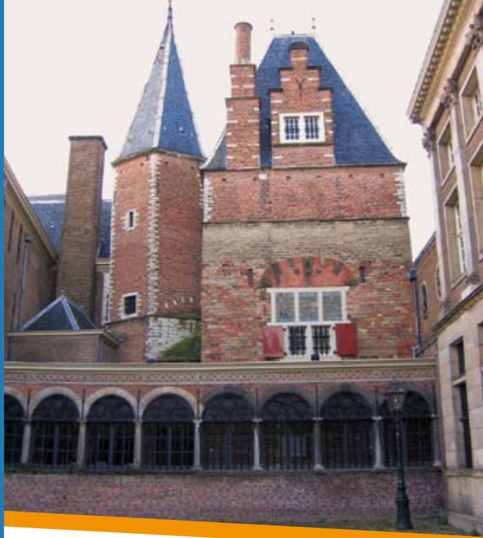
In het centrum van Leiden ligt het Gravensteen, gebouwd door de graaf van Holland.
