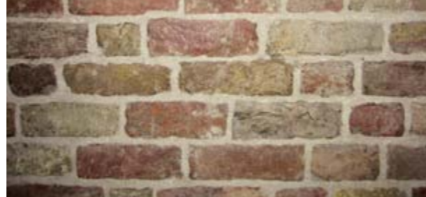
Het authentieke metselwerk van het Gravensteen neigt naar Noor(d)s verband.
