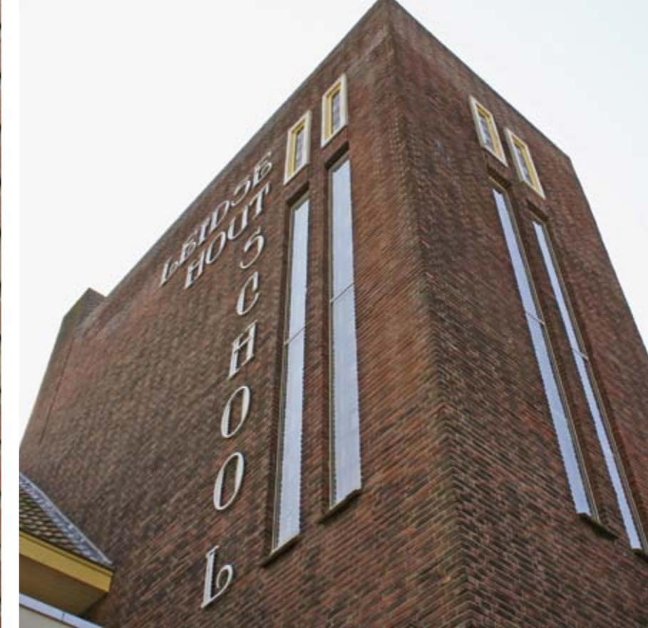
De karakteristieke Leidse Houtschool is een ontwerp van de Leidse architect A.T. Kraan.
