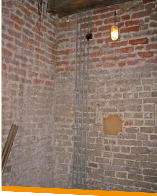
Vanaf de vierde verdieping bestaat de Rijnsburgse kerktoren van binnen uit baksteen.
