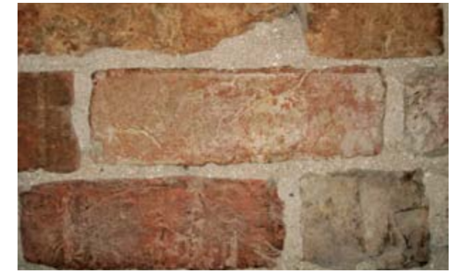
Sommige bakstenen vertonen plooiën van het in de mal drukken van de klei.
