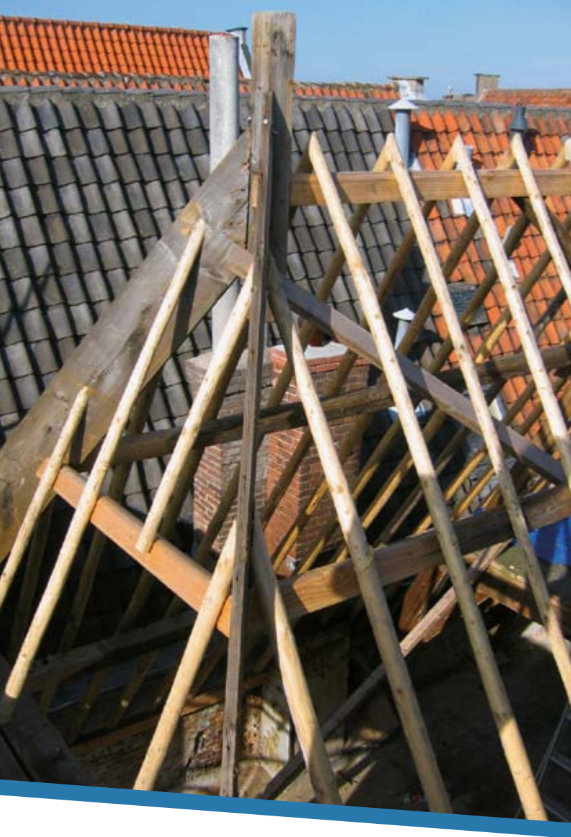
De open kap van Nieuwe Rijn 105 met goed zichtbaar de makelaar.
