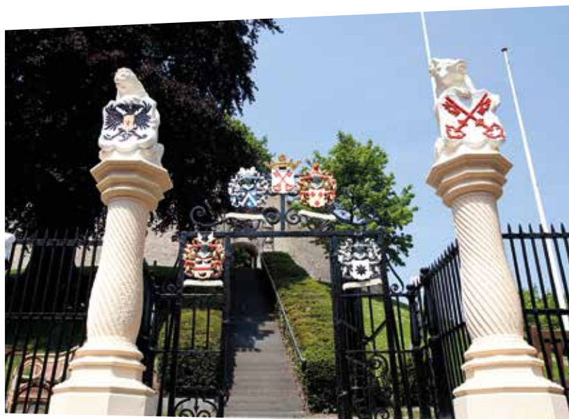
Herstel hekwerk van de Burcht
