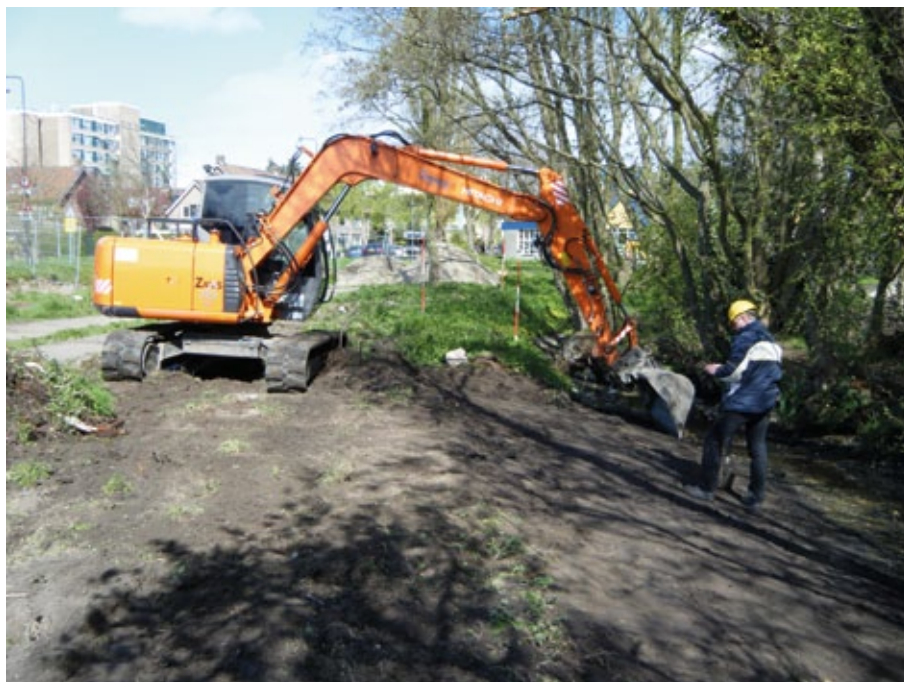
Afb. 4.1. De sloot ten westen van het geplande wandelpad was verland en moest worden open gegraven. Omdat de nieuwe sloot mogelijk dieper en breder werd dan de oorspronkelijke waterloop, zijn deze werkzaamheden intensief archeologisch begeleid.
