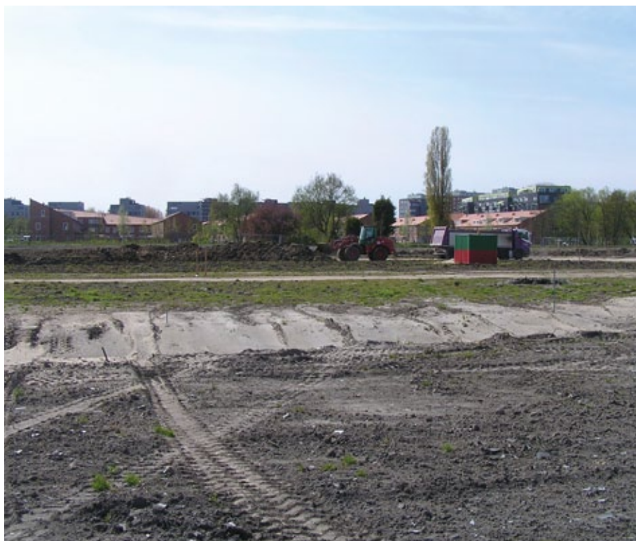
Afb. 5.1. Impressie van het onderzoeksterrein van fase 2. De foto is genomen vanaf het midden van het onderzoeksterrein richting het westen, waar de nieuwbouw zichtbaar is.
