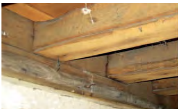
Detail van de balklaag met in de kinderbinten lengtegroeven en spijkergaatjes.
