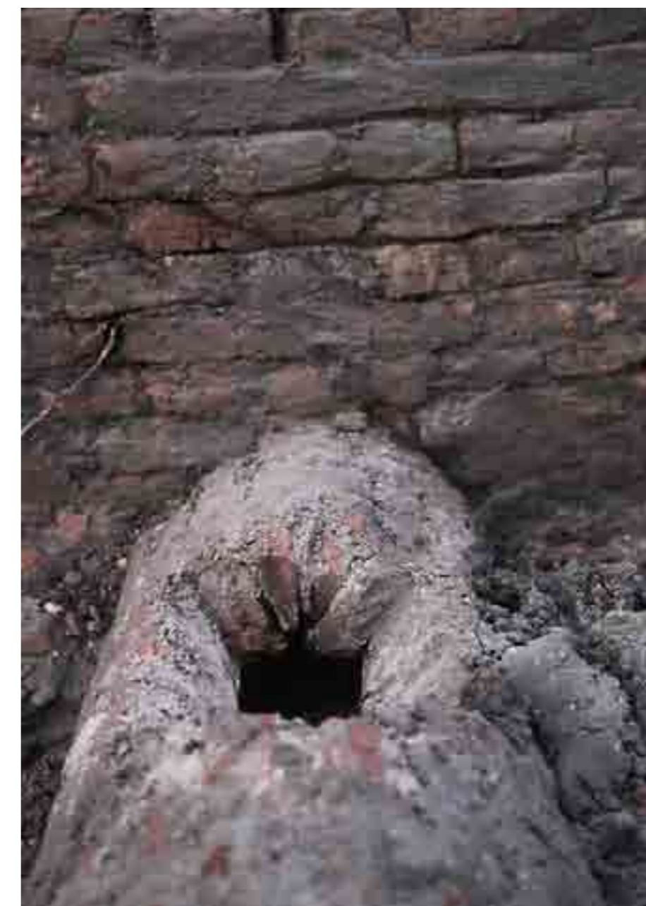
Afb. 9.6 Detailopname van de uitsparing in het metselwerk van de goot van huis 3. Wellicht betreft het een inlaat van een inpandig secreet.
