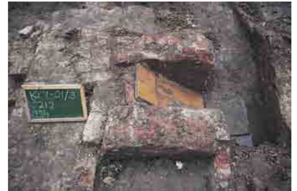
Afb. 9.3 Detailopname van de schuin aflopende inlaat in de goot bij huis 11. Wellicht betreft het de inlaat van een inpandig secret.
