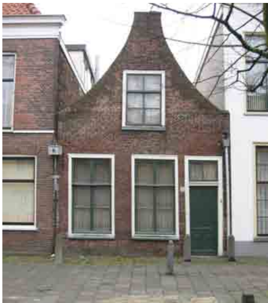
Afb. 8.5 Oosendruppen zijn op sommige plaatsen in de stad nog steeds terug te vinden in het straatbeeld. Zo is bijvoorbeeld aan de linkerkant van Middelstegegracht 143 een gedeeltelijk dichtgemetselde oosendrup aanwezig.
