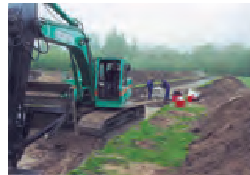
De graafmachinist haalt met de graafmachine de bovenste laag grond weg.
