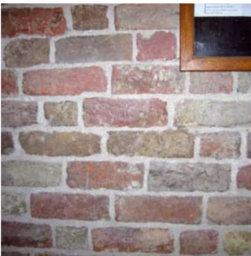
7 Origineel metselwerk van de toren in Noor(d)s verband.
