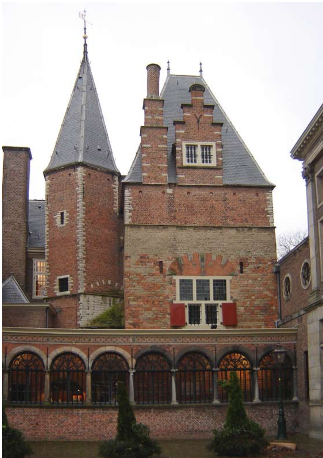
3 Het Gravensteencomplex met centraal de toren. Zichtbaar is het originele baksteenwerk, de ophoging in tufsteen en de tweede ophoging in baksteen, waarbij ook de traptoren is toegevoegd.
