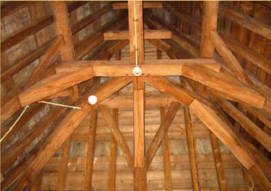
8 De kapconstructie van het Gravensteen.
