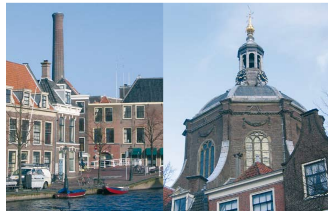
Identiteitsgebouwen; veel monumenten zijn het herkenningspunt van de wijk of straat. Schoorsteen van de elektriciteitscentrale Langegracht, koepel Marekerk.
