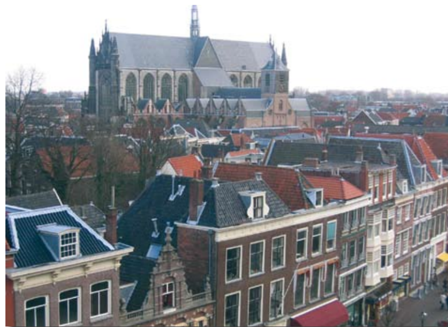
Het dakenlandschap in de binnenstad is een belangrijk element van het beschermd stadsgezicht.
