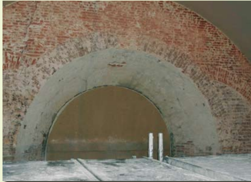
Oorspronkelijke 17e eeuwse gevel van de Luthers kerk (Hooglandsekerkgracht) komt tevoorschijn na het ontleisteren.
