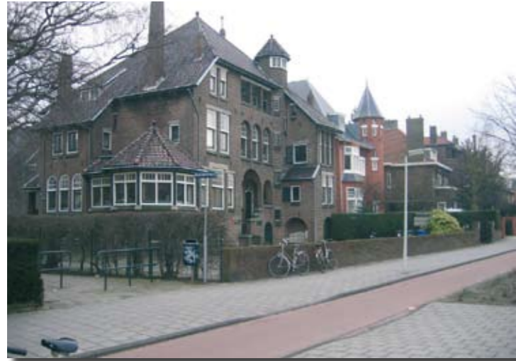
De Keet, ontwerp en woonhuis van architect Jesse is één van de vele bijzondere huizen die rond 1900 aan de Rijnsburgerweg, andere uitvalswegen en de singels zijn gebouwd.
